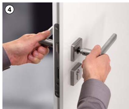
4 Postavite kvake i pričvrstite imbus vijkom
